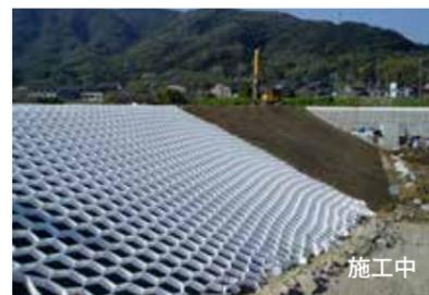
スパイク(合成繊維製法枠工法)との組み合わせ(調整池植生)
