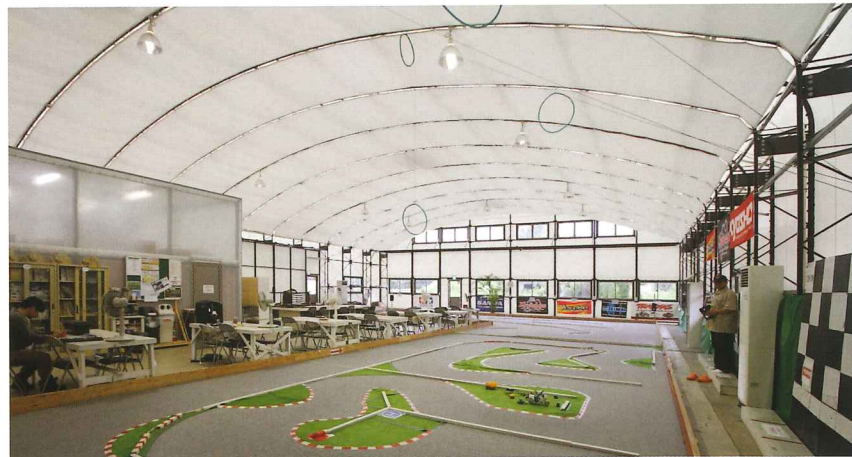
流山トントランド様 千葉県 店舗-ラジコンサーキット場 W18×L30×H5m / 540m 2 / 屋根膜:SCC125-ホワイト+内張ガラスクロス 間仕切部膜:ライトスルー
