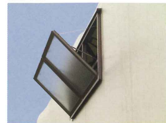
⑮ 排煙窓 (アルミ製)
