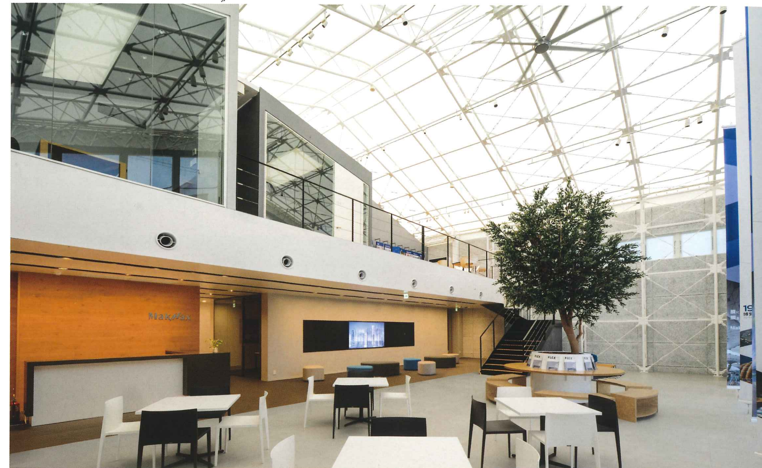
MakMax Flex Experience Center 大阪府 事務所(体感施設) W17.1×L20.1×H7.2m / 建築面積:344m 2 / 延床面積:550 m 2 (2階建て) / CMX220-ホワイト/外壁:ガルバリウム鋼板
