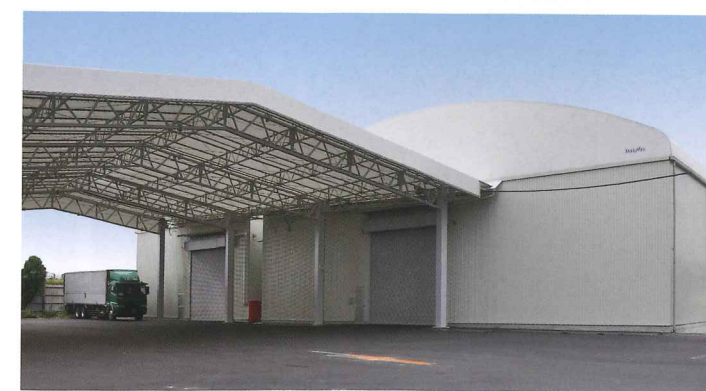
日本製紙物流株式会社尼崎 様 兵庫県 倉庫(製品) W26×L52.6×H7.3m / 1,368m 2 / W15×L57.5×H7.3m / 863m 2 / CMX220-ホワイト/外壁:ガルバリウム鋼板
