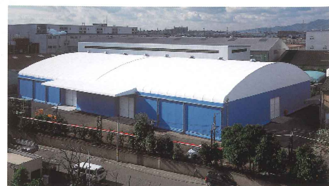
製造メーカー 様 兵庫県 倉庫(製品) W40×L65×H6m / 2,600m 2 / ウルトラマックスタイプC(防炎フッ素コート膜材) / 屋根:ホワイト / 壁:ライトブルー
