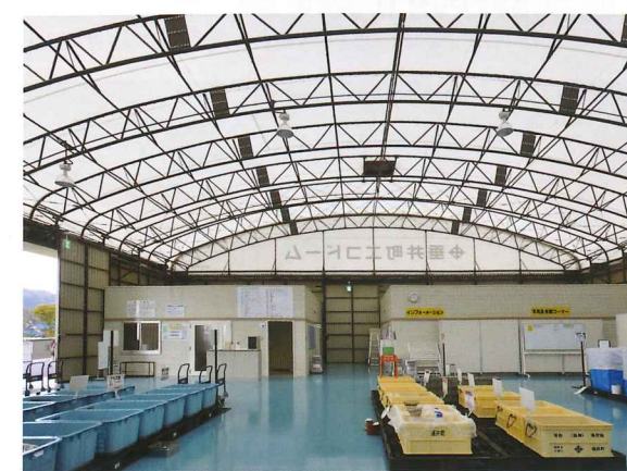
垂井町エコドーム様 岐阜県 リサイクル施設 W20×L30×H5m / 600m 2 / CMX220-ホワイト/外壁:ガルバリウム鋼板
