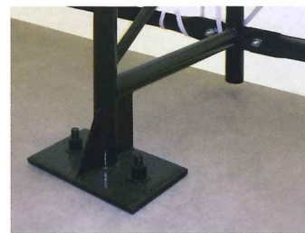
⑧ 主架構柱脚部
