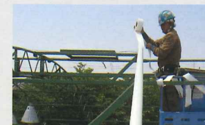
膜材張り替え時の骨材補修
