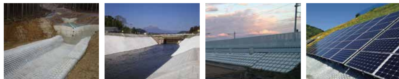
水路ライニング工
