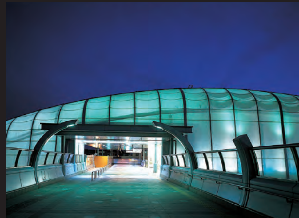
5 JR新沢駅 設計／JR東海 施工／JR東海建設
