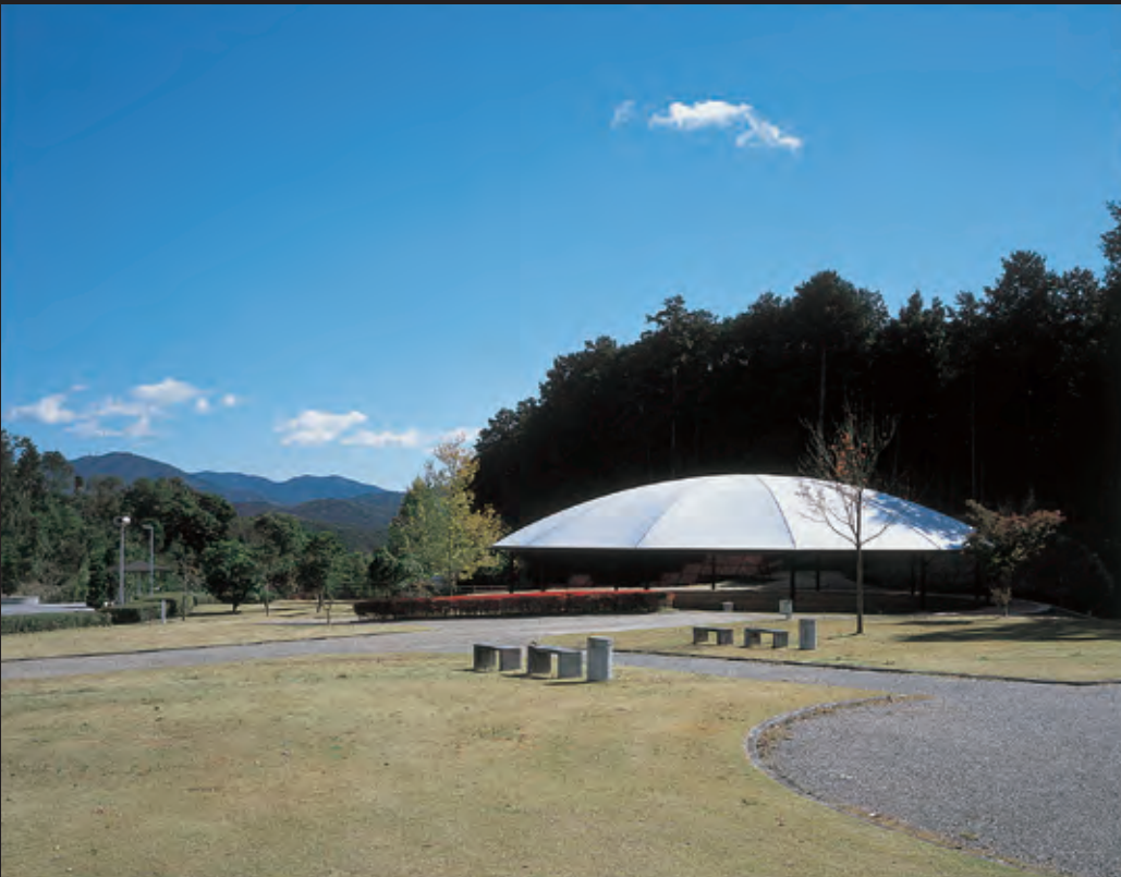
3 公園緑地整備工事(公共) 屋根付き広場建築工 設計／玉野総合コンサルタント 施工／松井建拓 4 葛西臨海水族園休憩施設 設計／谷口建築設計研究所 施工／山内工務店 5 那珂川水族園 (仮称) 野外休憩施設等新築工事 設計／イケタ設計事務所 施工／桜田建設 6 海ほたる 設計／日建設計 施工／大林・清水・前田・東亜・大日本JV
