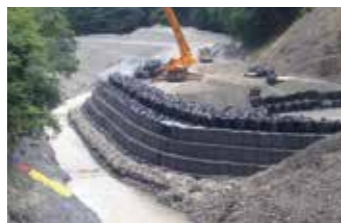
洪水に対応した仮締切護岸工
