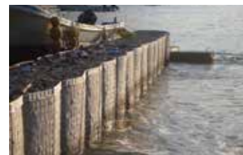
漁港嵩上げ土留工(海岸で使用)
