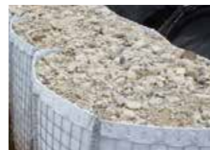
現地発生材を充填(再生材を使用)
