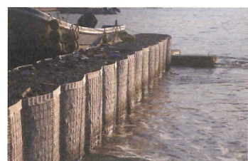
漁港嵩上げ土留工（海岸で使用）
