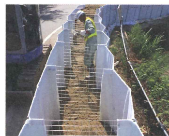
土砂の連続性（止水性確保）
