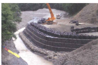
洪水に対応した仮締切護岸工
