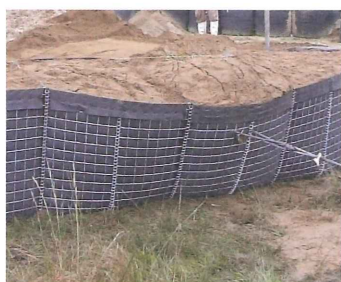
一体性比較実験状況
