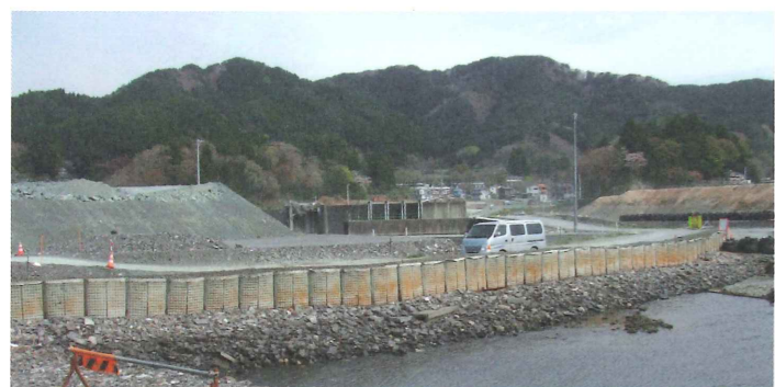
東日本大震災後（2012.3 施工）から3年以上経過（2015.5 時点）
