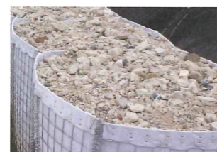
現地発生材を充填（再生材を使用）
