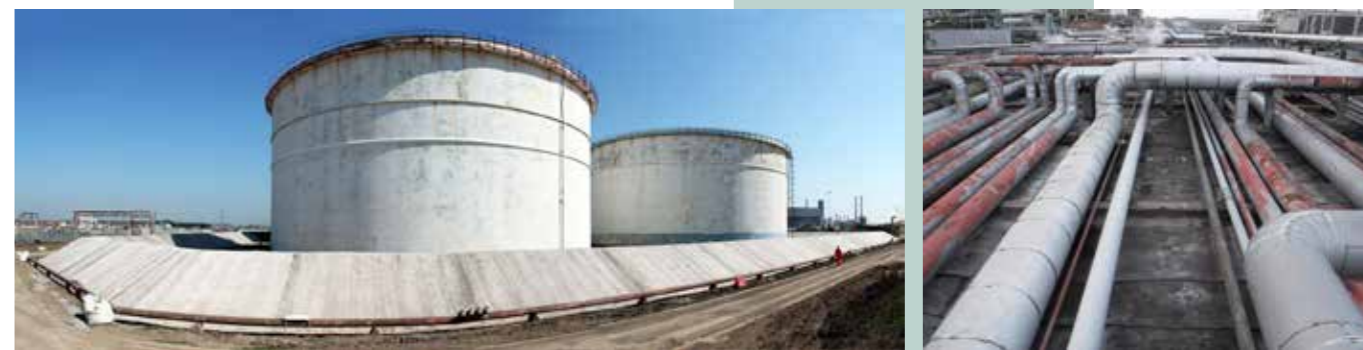
工場施設内 被覆工
