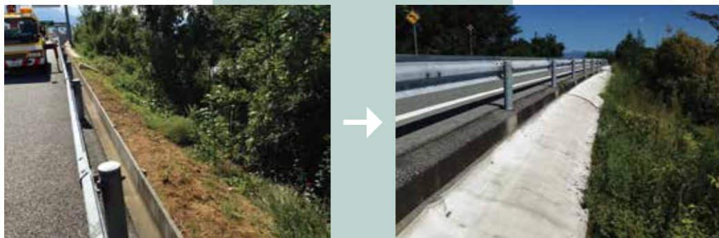
法面保護・防草防竹工
