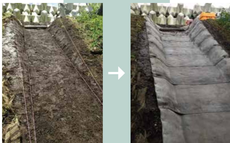
吐水口侵食防止工
