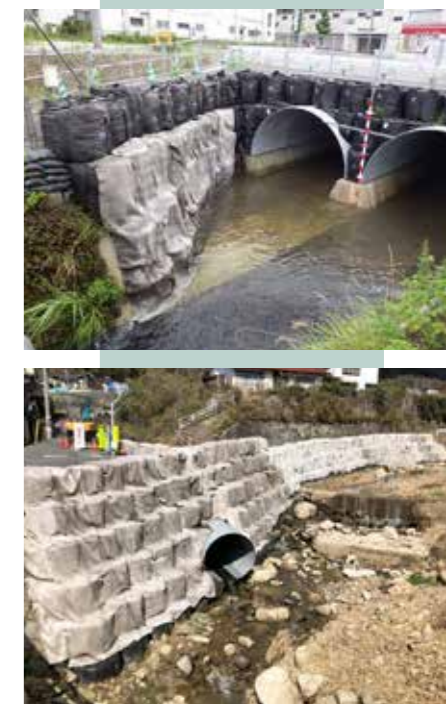
土のう被覆工
