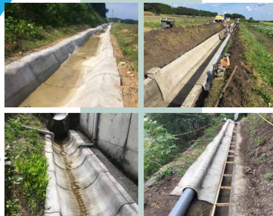
水路工・水路補修工
