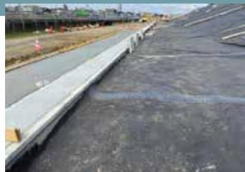
コンクリート構造物などへシートを接着する箇所はできる限り覆土工を行い、接着後にシートに引張力がかからないようにする
