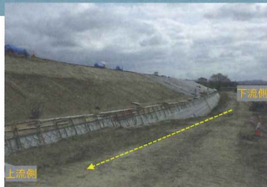
シートは下流側から上流側堤防天端から法尻方向へ展開する
