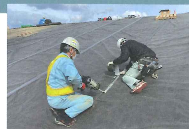
接着部(シート間)に隙間がないことを確認/接着剤塗布面にゴミや埃がないことを確認 専用接着剤1本で10cm幅×2.5m程度を塗布後、帯シートを貼り合わせて接合する 接着剤用帯シート貼り合わせ後は、接着部が剥がれないように、完全硬化するまで接着部周辺を歩かないように注意する
