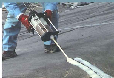
接着部(シート間)に隙間がないことを確認/接着剤塗布面にゴミや埃がないことを確認 専用接着剤1本で10cm幅×2.5m程度を塗布後、帯シートを貼り合わせて接合する 接着剤用帯シート貼り合わせ後は、接着部が剥がれないように、完全硬化するまで接着部周辺を歩かないように注意する
